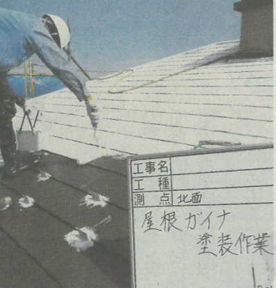
日進産業が開発した塗料「ガイナ」の施工作業。塗るだけで断熱できる
