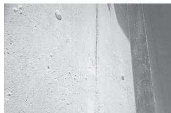
ジャンカが発生しているコンクリート壁面。
