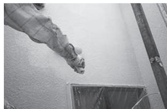
吹き付け仕上げの外壁の上塗り。
