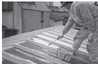
トタン屋根鉄部に、エポキシ系さび止めで下地処理。
