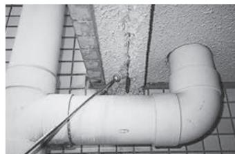
爆裂箇所の斫（はつ）り作業。
