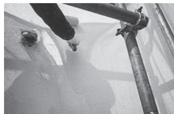
吹き付け仕上げの外壁の中塗り。
