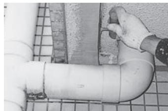
プライマーで下塗りした後、樹脂モルタルを充填し、成形。
