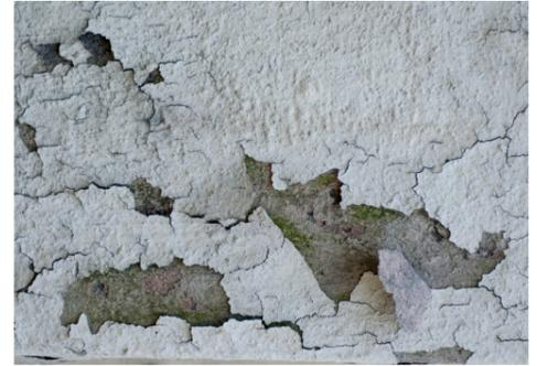
高圧洗浄により屋根材や壁材の脆弱部などで破損の恐れがある場合を除き、**150kgf/cm<sup>2</sup>以上の水圧**で洗浄を行って下さい。
