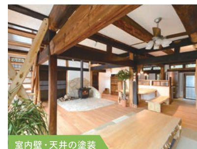
室内壁・天井の塗装
