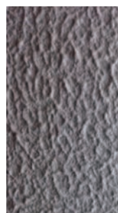
▲ローラー仕上げ
